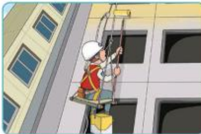
5 달비계 작업 시 안전대 및 구명줄 설치
