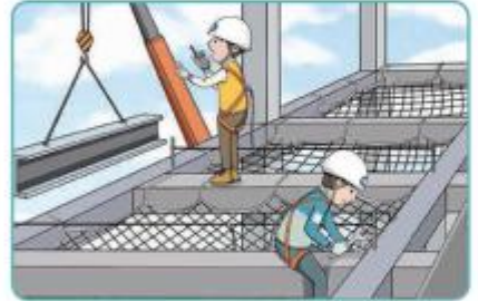
6 안전대 착용 시 안전대 부착설비 설치
